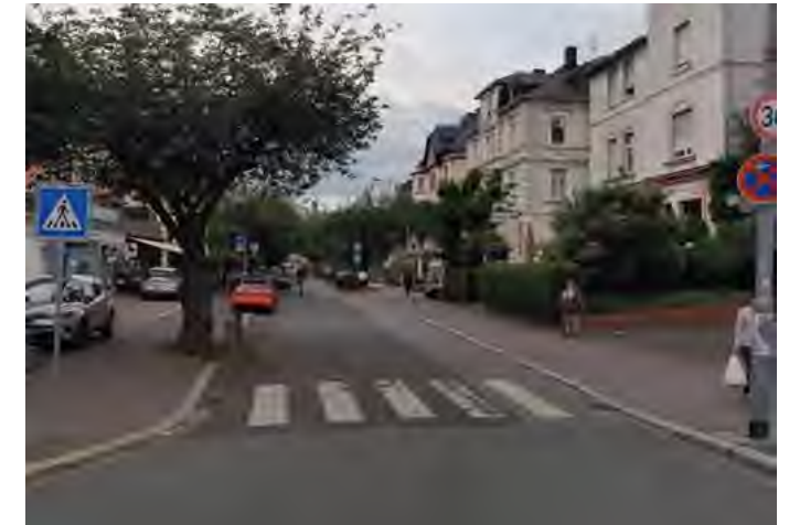
Fehlende Barrierefreiheit am FGÜ in der Bismarckstraße (cyclomedia, 2024)
