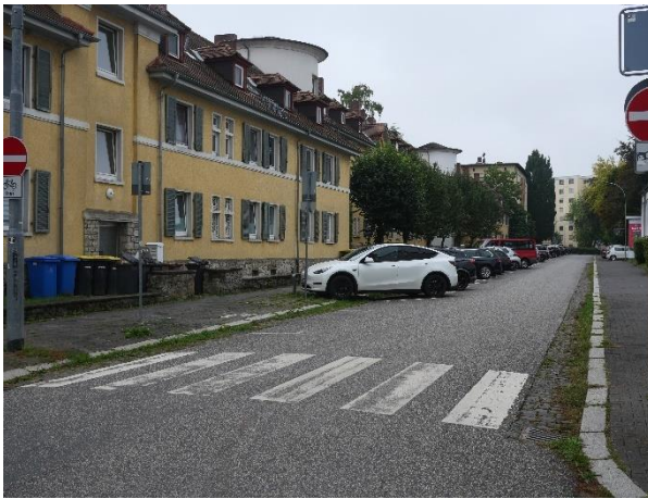
Abbildung 83: Fehlende Bordsteinabsenkung am Fußgängerüberweg in der Kettelerstraße (eigene Fotoaufnahme, 2025)
