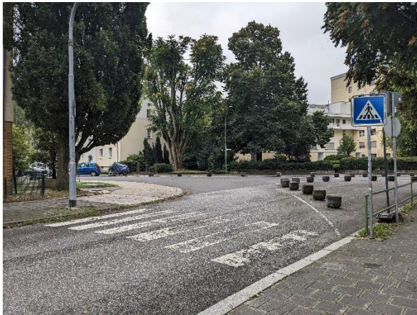
Abbildung 28: Einengung der Fahrbahn im Knotenpunktbereich Mainzer Tor-Weg / Kettelerstraße (eigene Fotoaufnahme, 2025)
