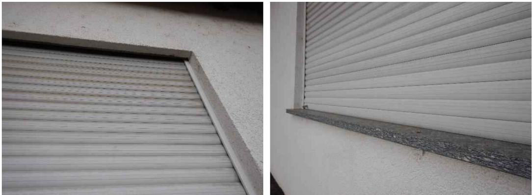
**Abbildung 8:** Kotspuren auf Fensterbänken unter Rollladenkästen fehlten.
