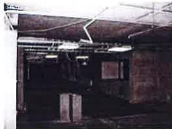
Die Lagerräume der ehemaligen Kegelbahn müssen zum Flur mittels F30 Türen ausgestattet werden. Sämtliche Wand-, Decken- und Bodenflächen sind auszutauschen.
