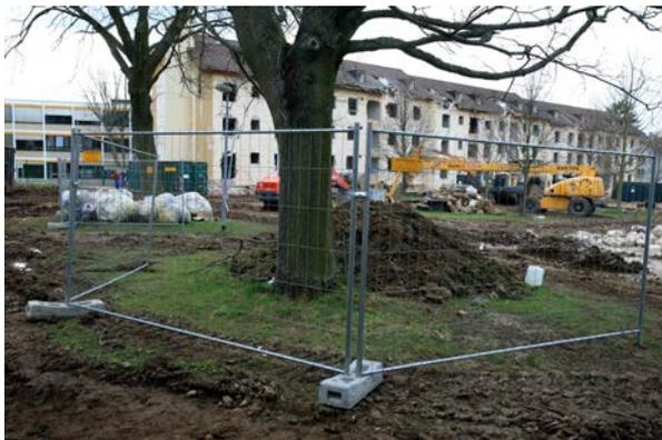
Abb. 6: Bauzäune als Schutzmaßnahme für den Baumbestand
