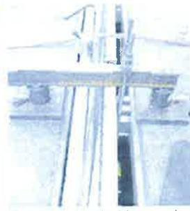
Die parallel zur Fahrtrichtung verlaufenden Traversen müssen angehoben werden, um Gleitlager zu installieren.
